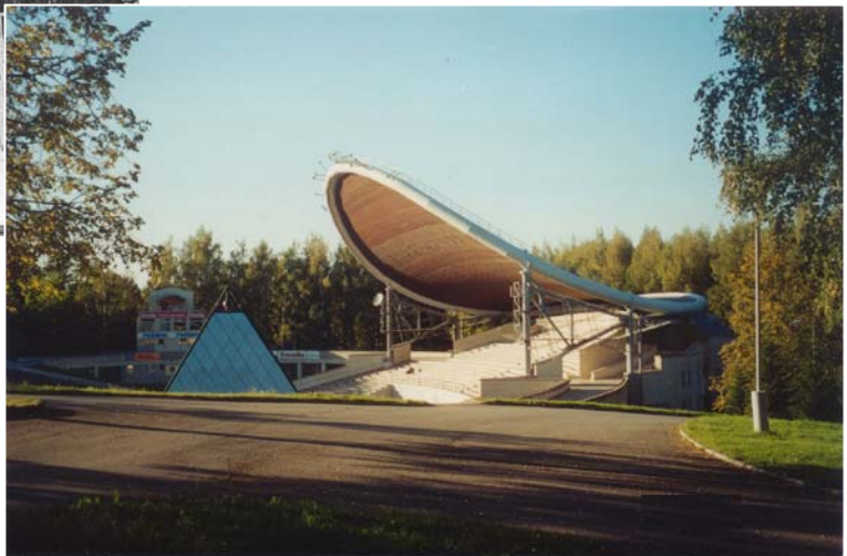
Foto 6. Tallinna laululava kõlaekraani kontuurkaared toetuvad massiivsetele kontraforssidele.
