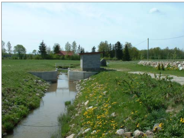
Joonis 1. Veeseire automaatjaam veekvaliteedi ja äravoolu kontrolliks.
